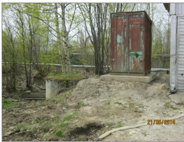
Рисунок 1.7 Будка перед насосной станцией с отключающей арматурой.
