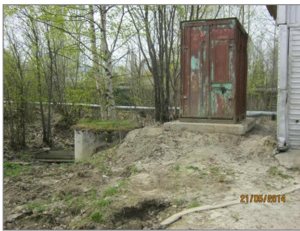
Рисунок 1.7 Будка перед насосной станцией с отключающей арматурой.
