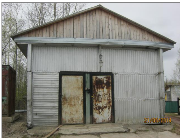
Рисунок 1.6 Здание канализационной насосной станции п.Сентябрьский
