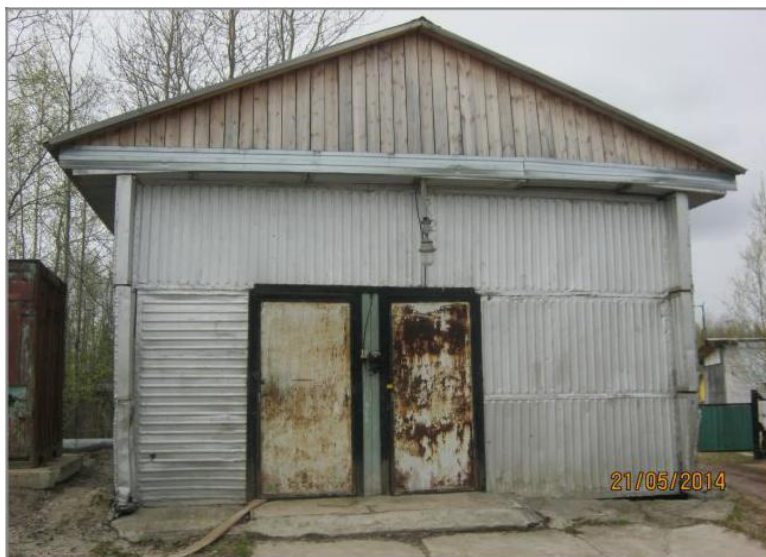
Рисунок 1.6 Здание канализационной насосной станции п.Сентябрьский
