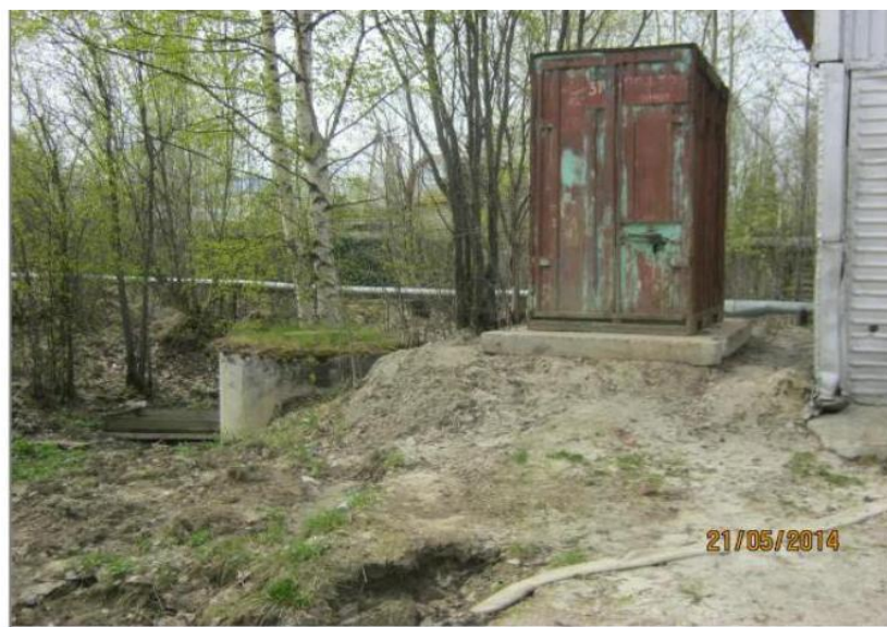
Рисунок 1.7 Будка перед насосной станцией с отключающей арматурой.
