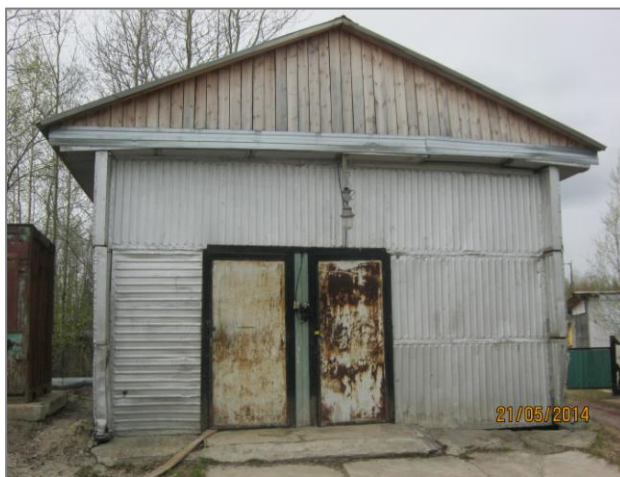
Рисунок 1.6 Здание канализационной насосной станции п.Сентябрьский
