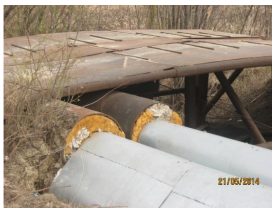
Рисунок 1.4 - Теплоизоляция сетей наземной прокладки сетей водоснабжения
